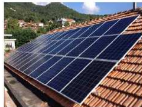
Esempio di pannelli fotovoltaici appoggiati, complanari alla falda, ma decontestualizzati.
